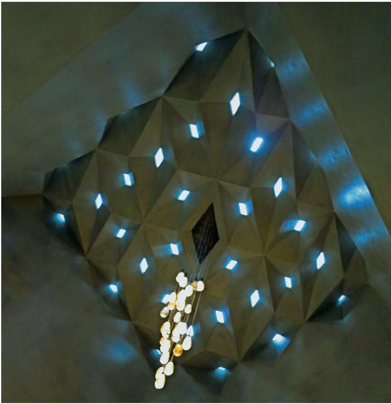
Die «Kuppel» erfuhr eine besondere Gestaltung. Das Tageslicht fällt durch Nischen in den Hauptraum.
